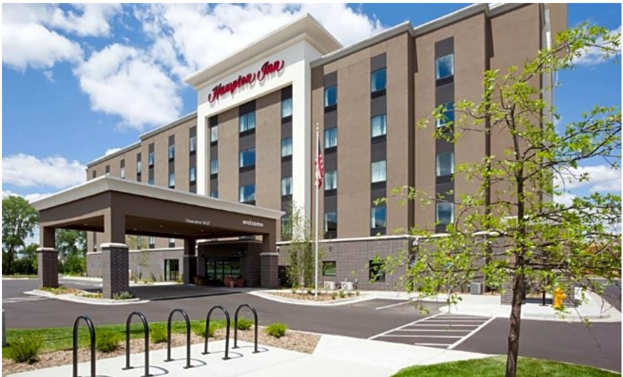
Drywall on wood stud hotels
